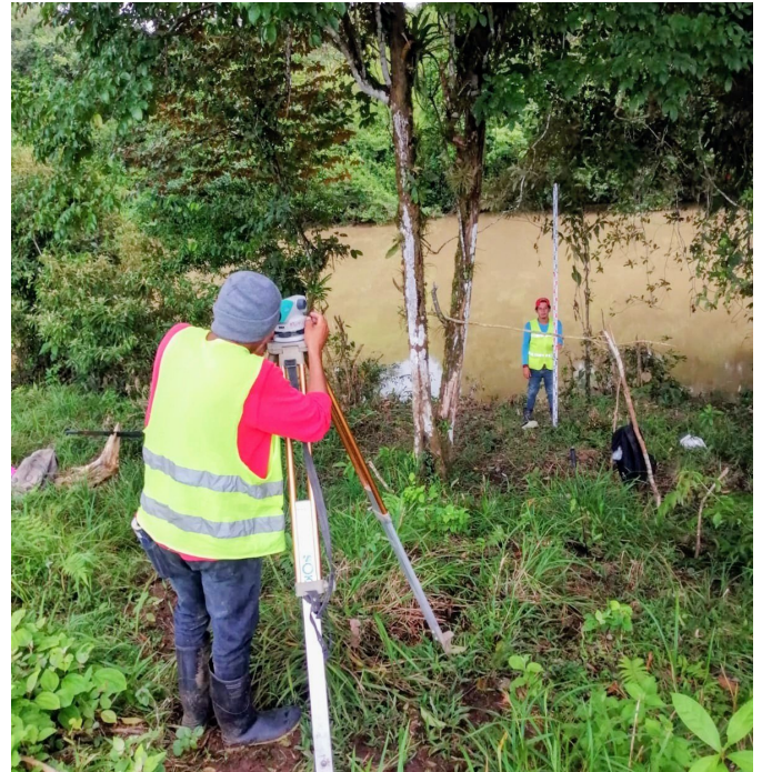
TRASLADO DE COTAS Y CONTROL VERTICAL
