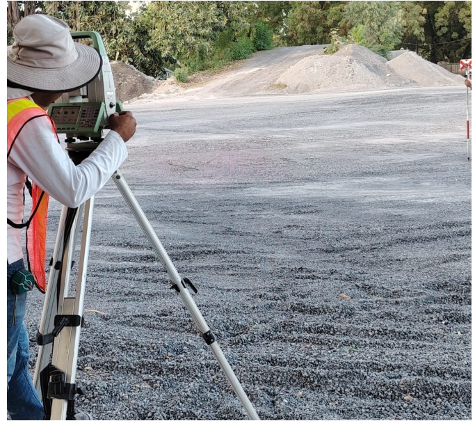
CONTROL GEOMÉTRICO Y REPLANTEO
