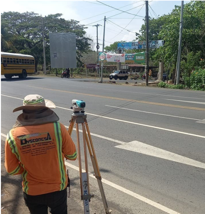
NIVELACIÓN EN CARRETERAS Y RASANTES
