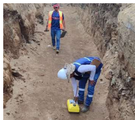
Determinación de Grado de Compactación de Suelo
