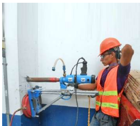
Extracciones de Núcleo en Columna
